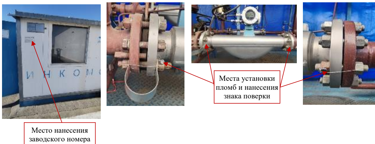
Рисунок 2 – Места нанесения заводского номера, знака поверки и места установки пломб
