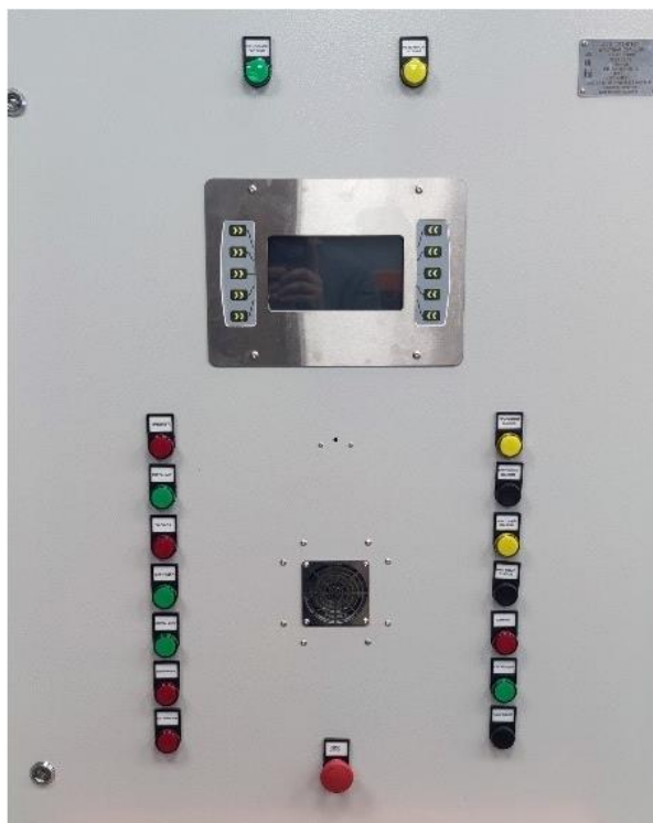
а) шахтная станция управления (ШСУ)
