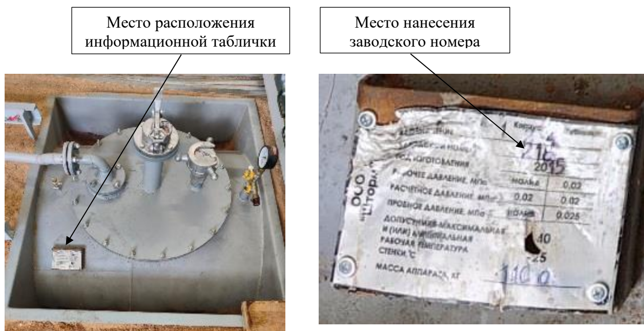
Рисунок 3 – Общий вид горловины и замерного люка резервуара № 218, обозначение места нанесения заводского номера на информационную табличку
