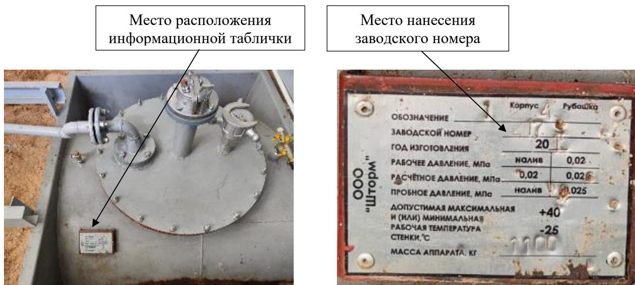
Рисунок 2 – Общий вид горловины и замерного люка резервуара № 217, обозначение места нанесения заводского номера на информационную табличку
