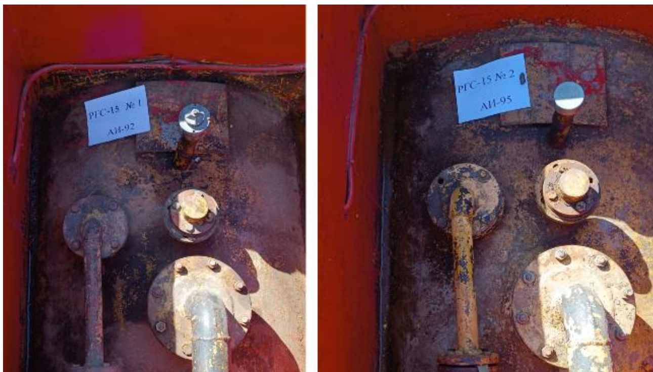
Рисунок 2 – Горловины резервуаров РГС-15 зав.№№ 1, 2
