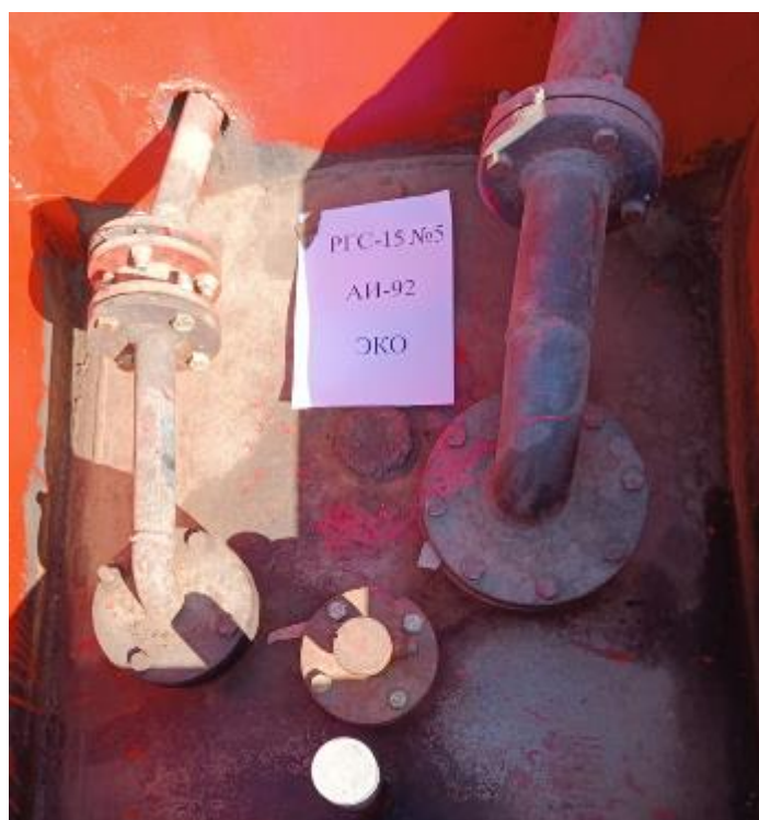
Рисунок 4 – Горловина резервуара РГС-15 зав.№ 5
