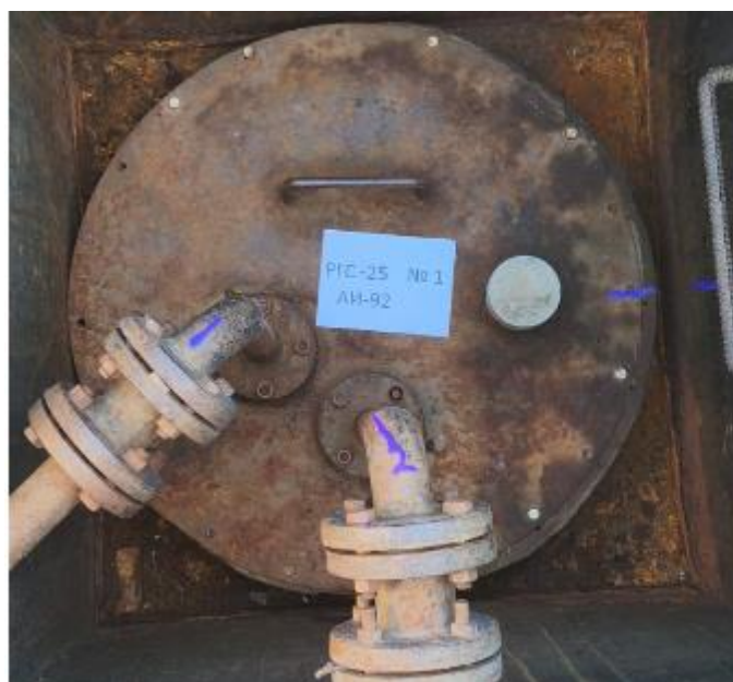
Рисунок 4 – Горловины резервуаров РГС-25 зав.№№ 1, 2
