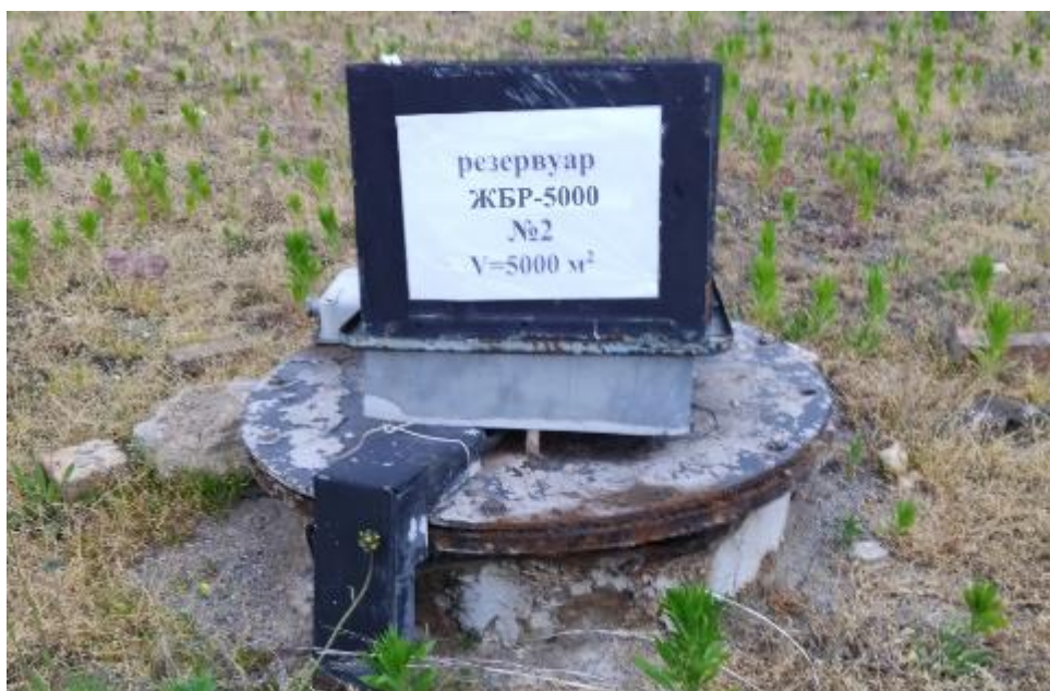
Рисунок 2 – Горловина резервуара ЖБР-5000 № 2
