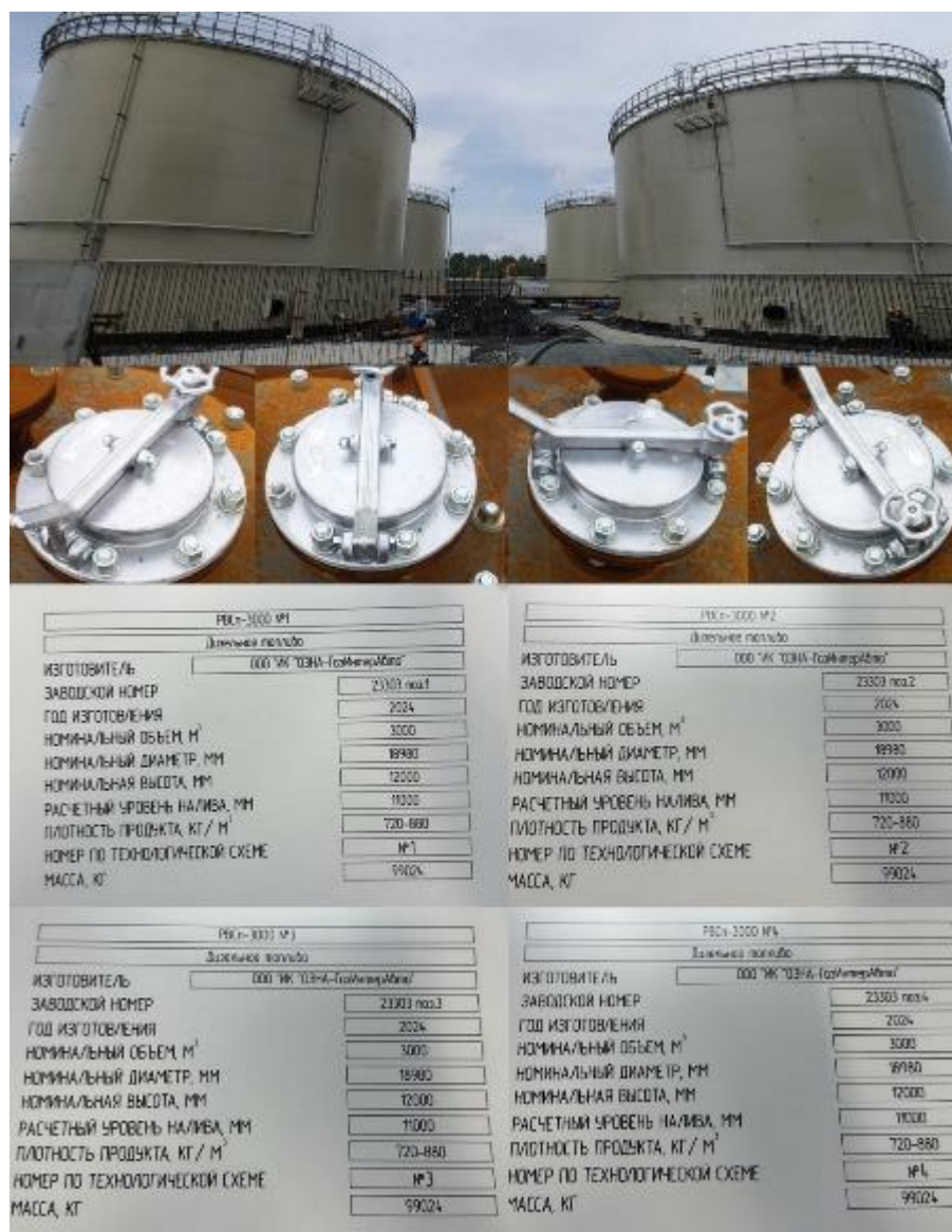
Рисунок 1 – Фотографии общего вида резервуаров вертикальных цилиндрических стальных с понтоном RBCп-3000 (№№ 23303 поз.1, 23303 поз.2, 23303 поз.3, 23303 поз.4), горловин замерных люков и заводских номеров
