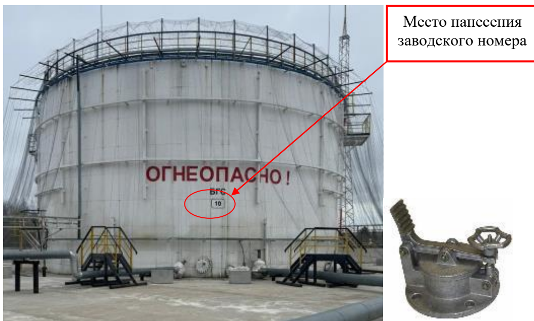
Рисунок 1 – Общий вид резервуара и замерного люка РВСП-5000 зав. № 10
