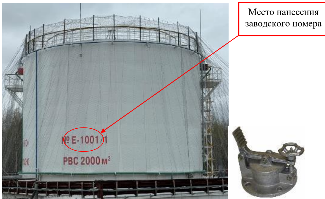
Рисунок 1 – Общий вид резервуара и замерного люка РВС-2000 зав. № Е-1001/1
