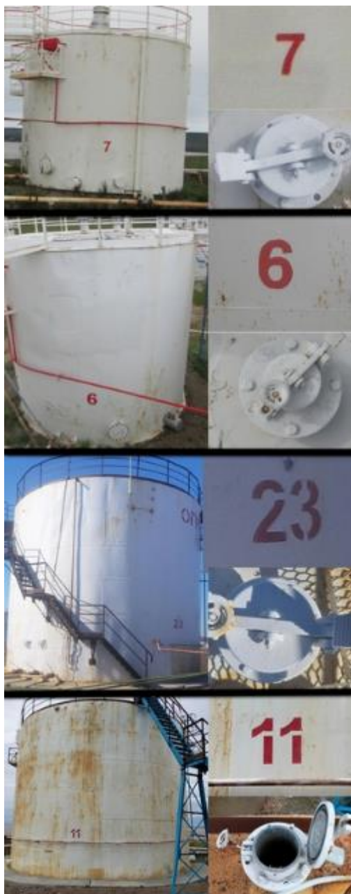
Рисунок 1 – Фотографии общего вида резервуаров стальных вертикальных цилиндрических РВС-200(№№ 6,7), РВС-700(№23), РВС-1000(№11), их горловин замерного люка и заводских номеров
