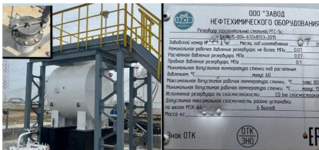
Рисунок 1 – Фотография общего вида резервуара РГС-5 (№4410) горловины и заводского номера
