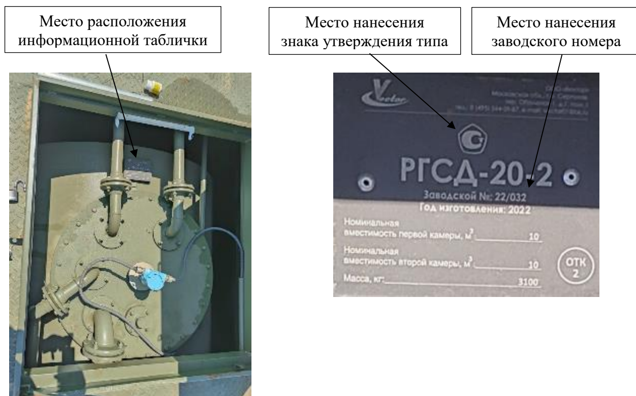
Рисунок 2 – Общий вид горловины резервуара, обозначение места нанесения заводского номера на информационную табличку
