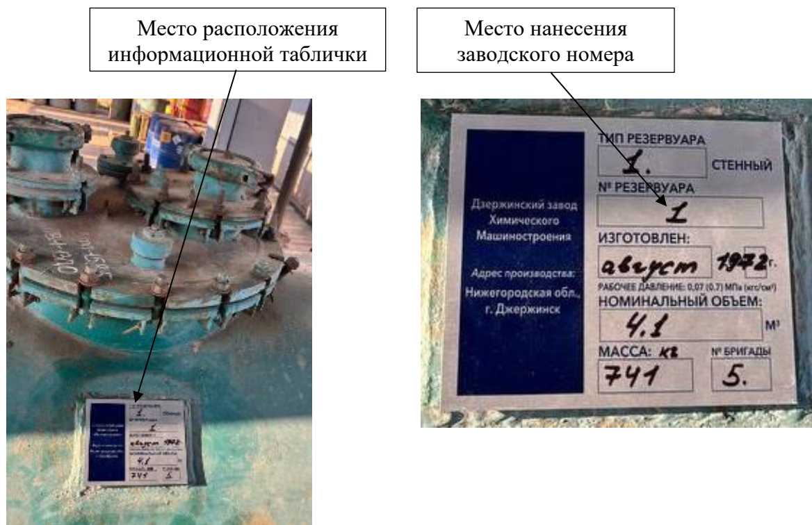
Рисунок 2 – Общий вид горловины и замерного люка резервуара № 1, обозначение места нанесения заводского номера на информационную табличку
