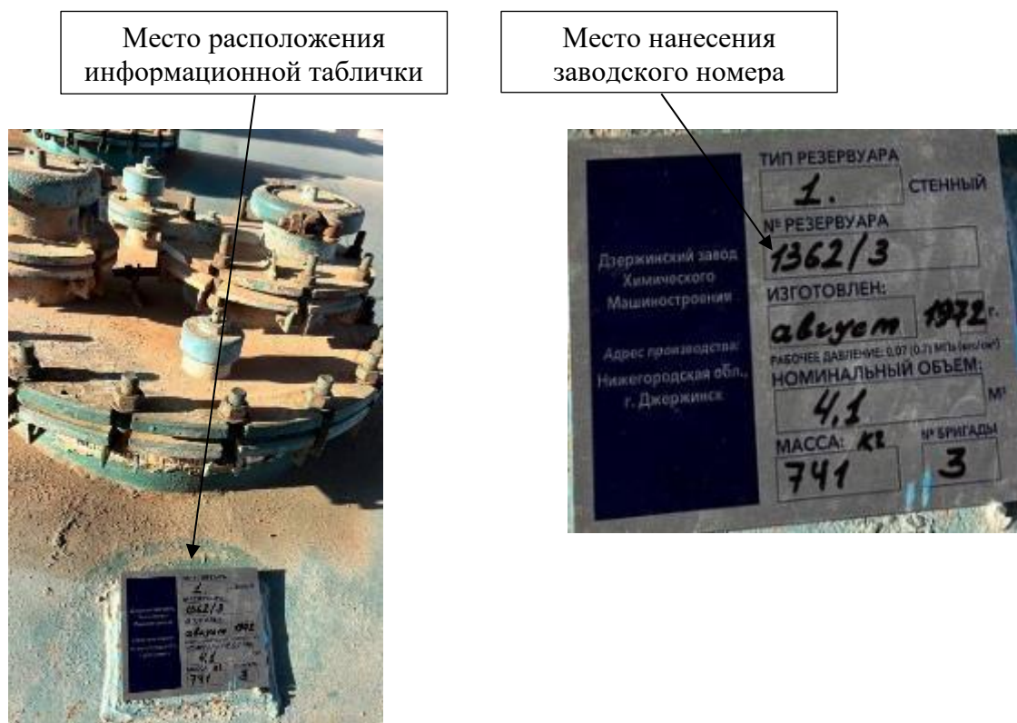
Рисунок 4 – Общий вид горловины и замерного люка резервуара № 1362/3, обозначение места нанесения заводского номера на информационную табличку
