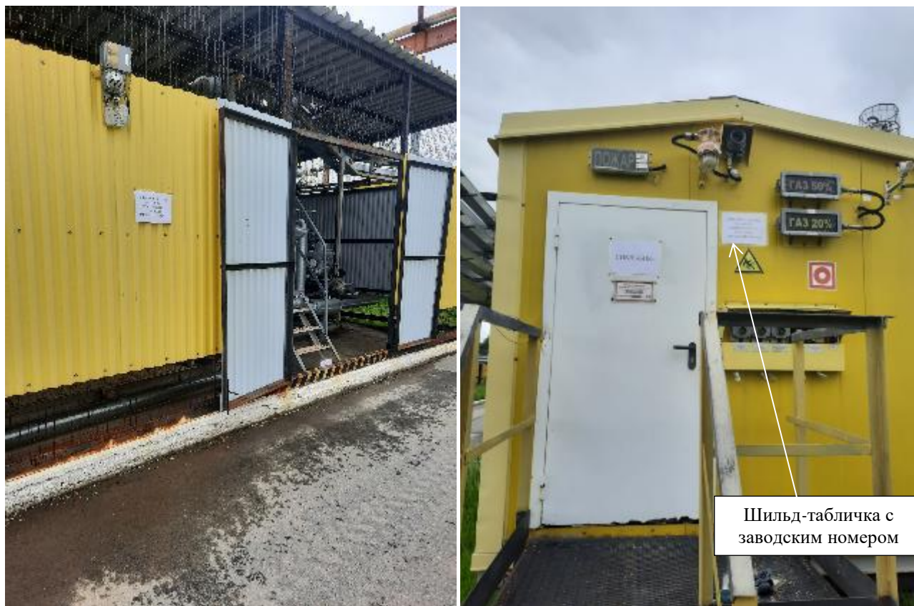
Рисунок 1 – Общий вид СИКН и место крепления шильд-таблички
