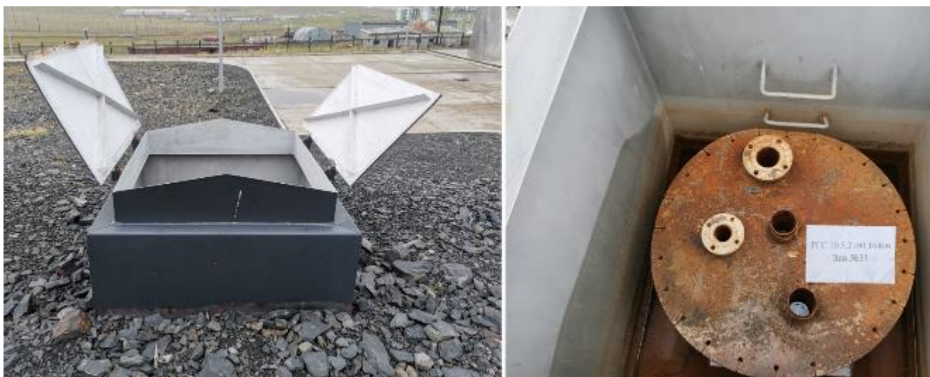
Рисунок 2 – Горловина резервуара РГС 10.5.2100.16406 зав.№ 31
