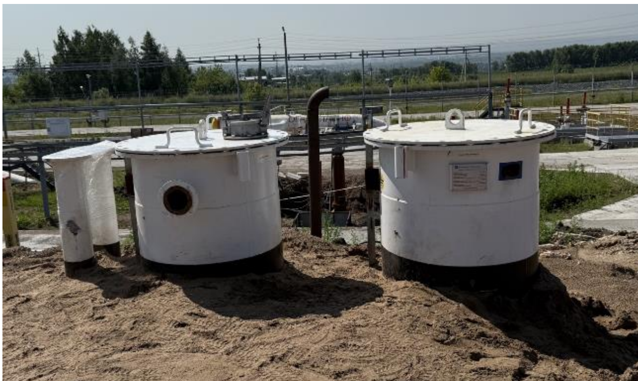
Рисунок 3 – Горловины и измерительный люк резервуара ЕП-12,5-2000-1500-А-С0-ХЛ1 зав.№ 330
