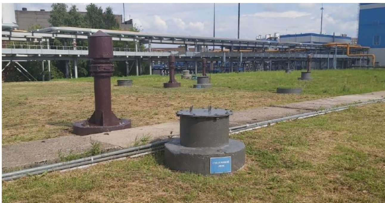
Рисунок 2 – Люки резервуара РЖБП-10000 № 2
