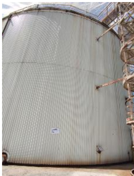
Рисунок 1 – Общий вид резервуаров стальных вертикальных цилиндрических РВСС-3000
