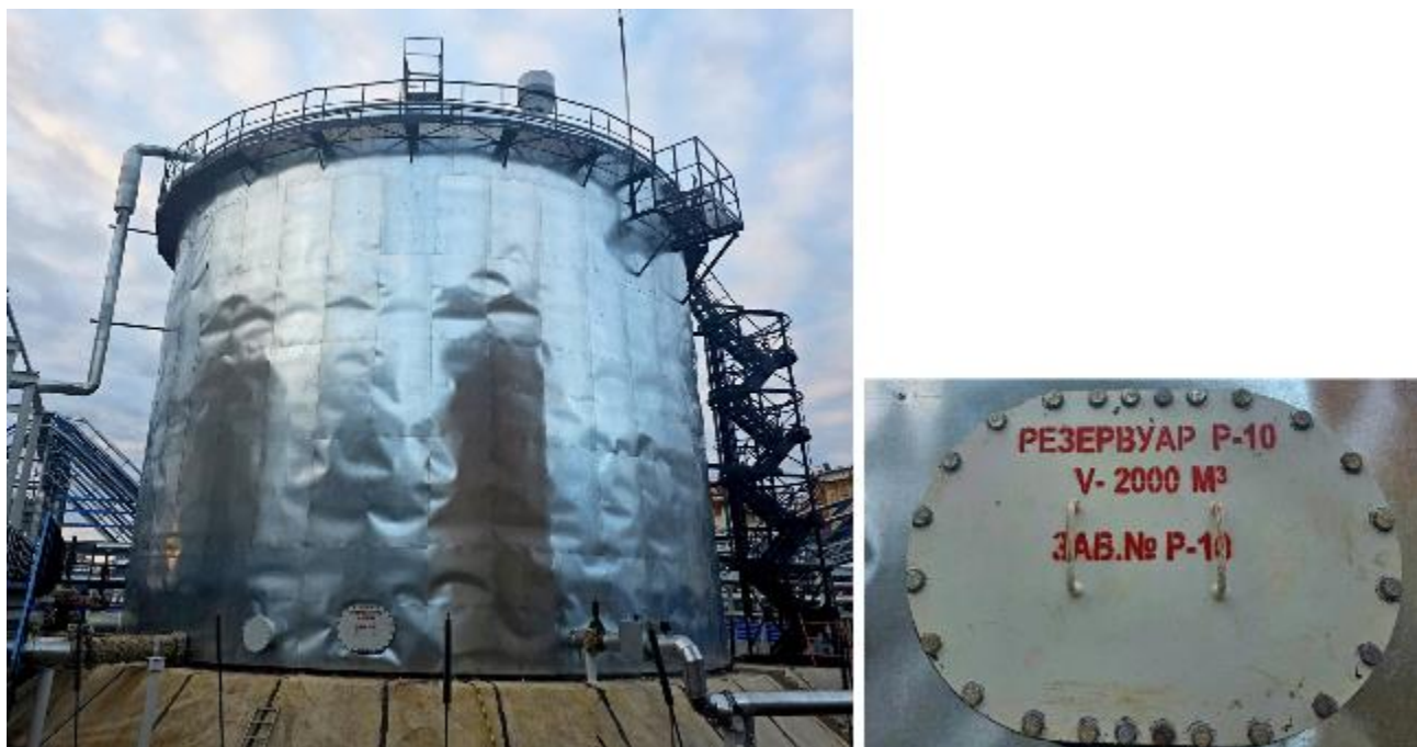
Рисунок 1 – Общий вид резервуара РВС-2000 зав. № Р-10 и место нанесения заводского номера
