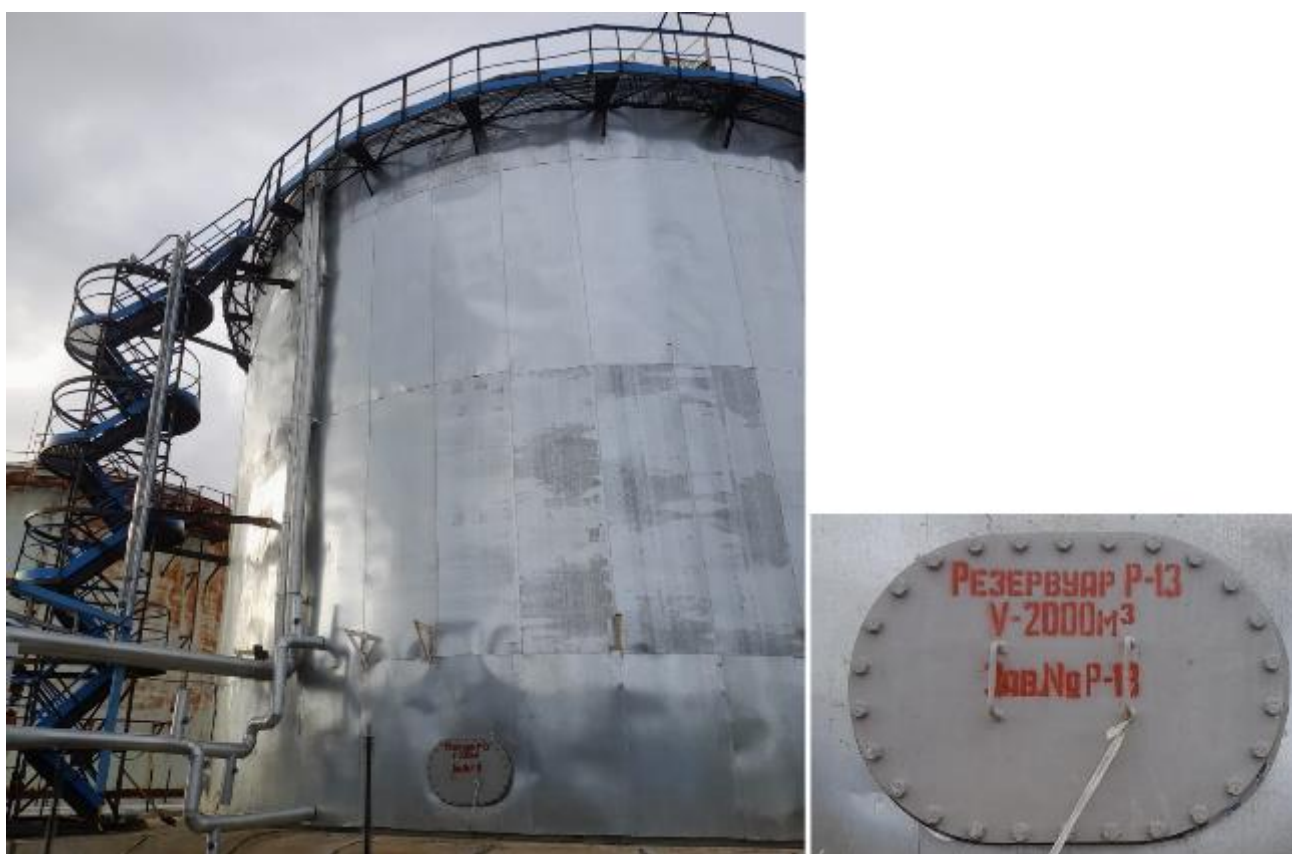
Рисунок 2 – Общий вид резервуара РВС-2000 зав. № Р-13 и место нанесения заводского номера
