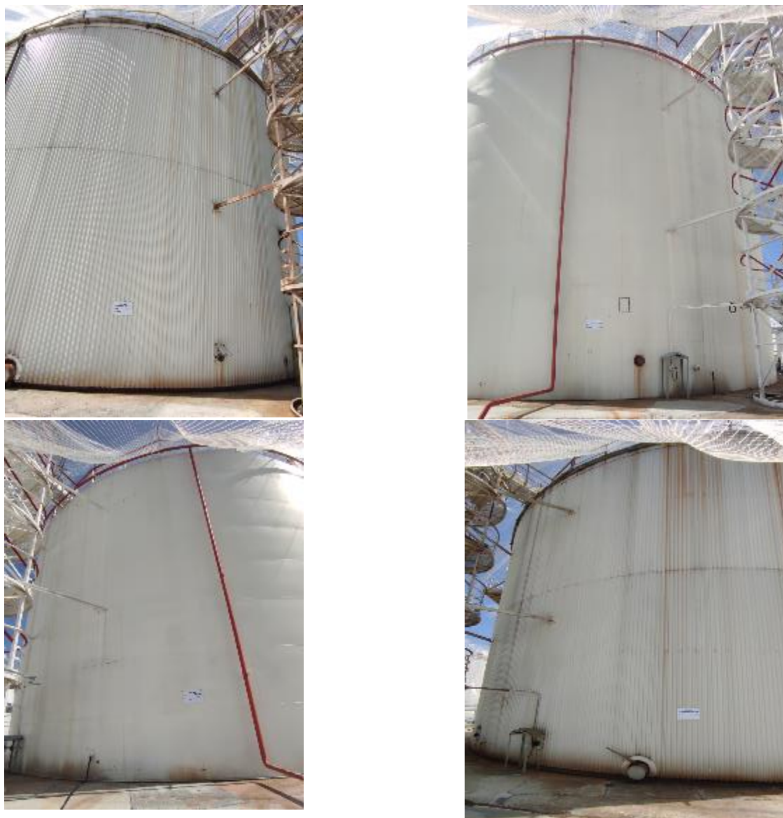
Рисунок 1 – Общий вид резервуаров стальных вертикальных цилиндрических РВСС-3000
