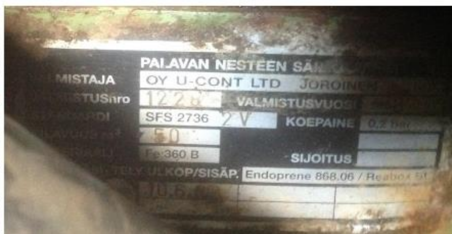
Рисунок 2 – Маркировочная табличка и горловина резервуара РГС-50 зав.№ 1228
