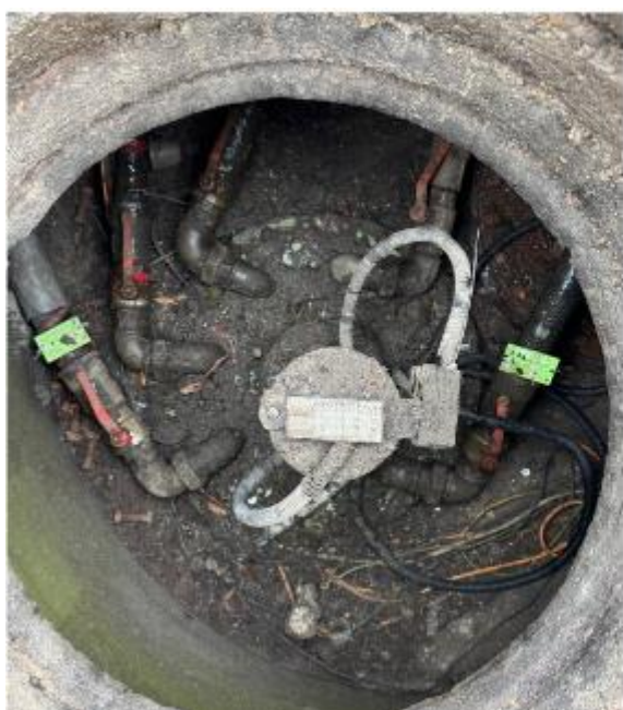
Рисунок 4 – Маркировочная табличка и горловина резервуара РГС-50 зав.№ 1230
