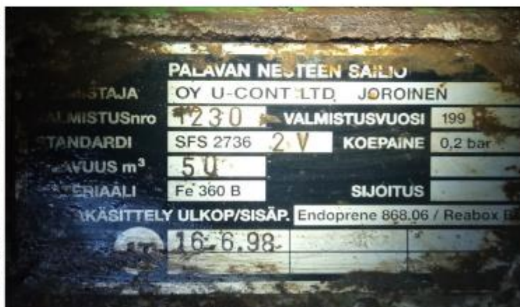
Рисунок 4 – Маркировочная табличка и горловина резервуара РГС-50 зав.№ 1230
