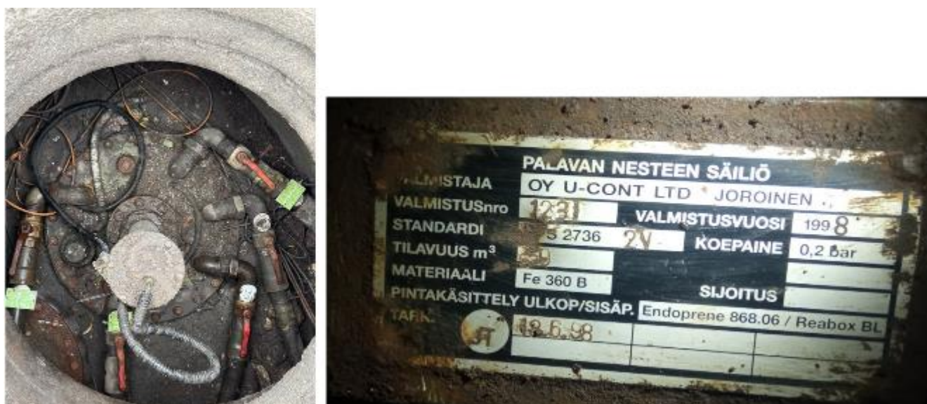
Рисунок 5 – Маркировочная табличка и горловина резервуара РГС-50 зав.№ 1231
