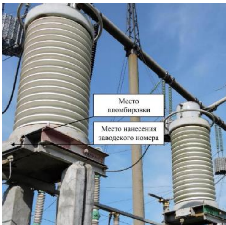
Рисунок 1 — Общий вид средства измерений с указанием места пломбировки и места нанесения заводского номера
