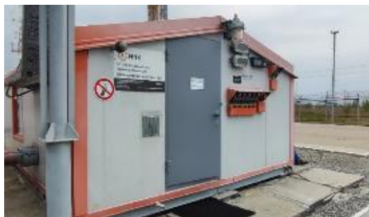
Рисунок 1 – Блок-бокс блока измерений качества нефти
