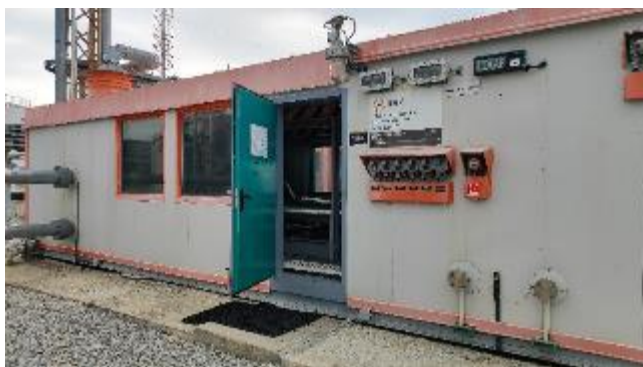
Рисунок 3 – Блок-бокс стационарной трубопоршневой поверочной установки
