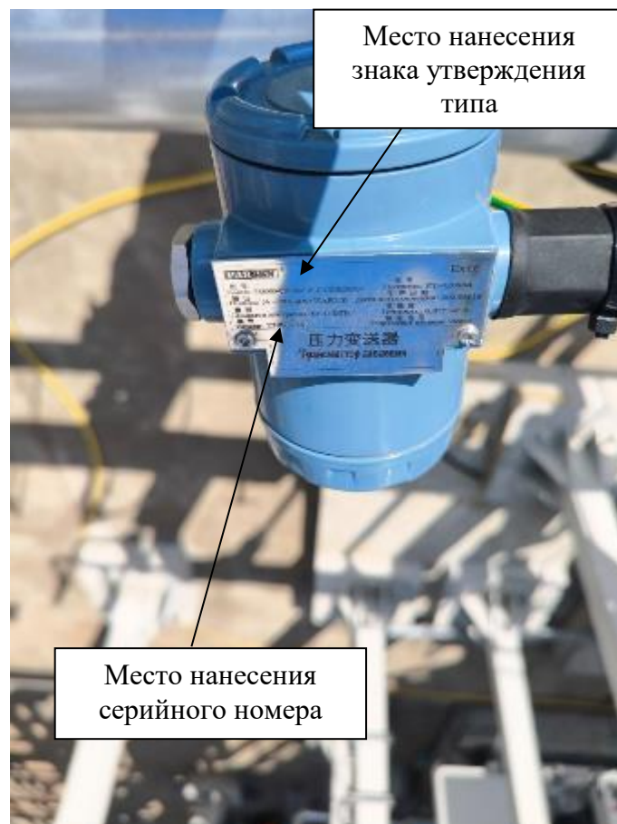
Рисунок 1 – Общий вид трансмиттеров с указанием места нанесения серийного номера и места нанесения знака утверждения типа
