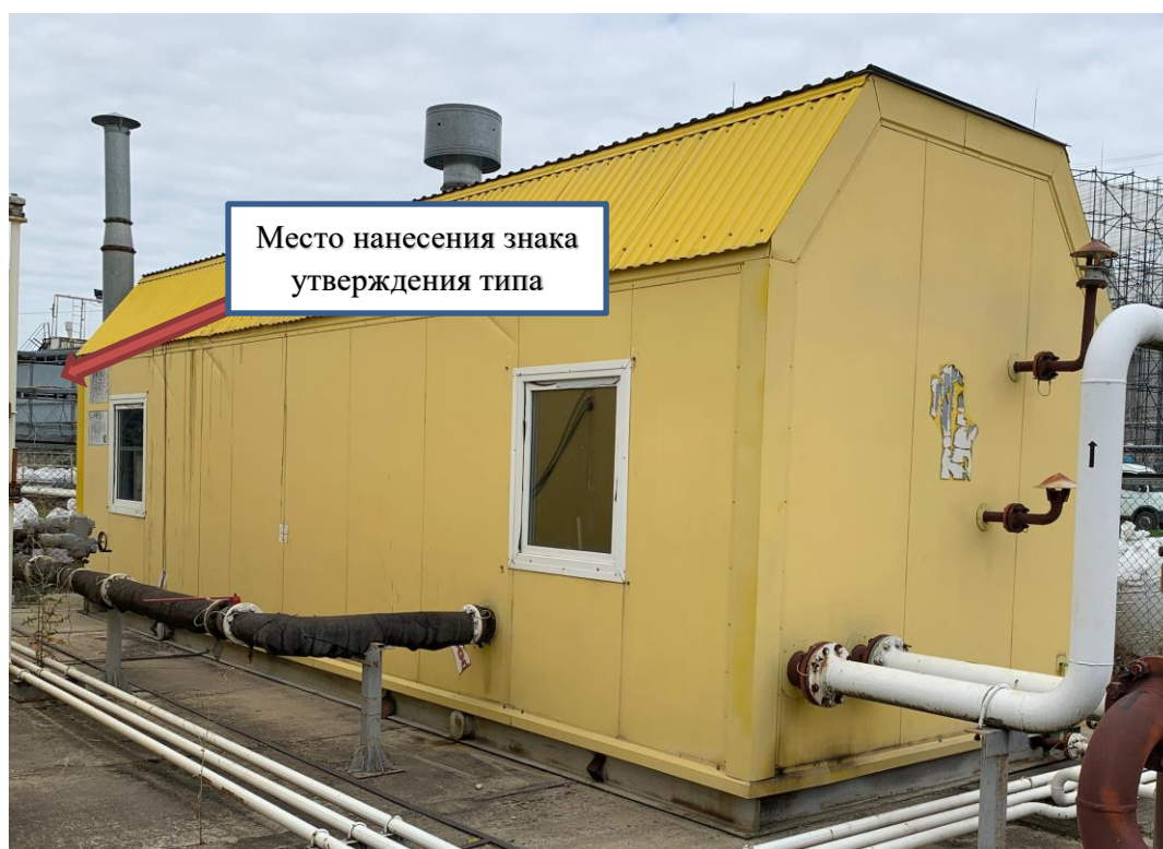
Рисунок 1 – Внешний вид СИКНП и место нанесение знака утверждения типа
