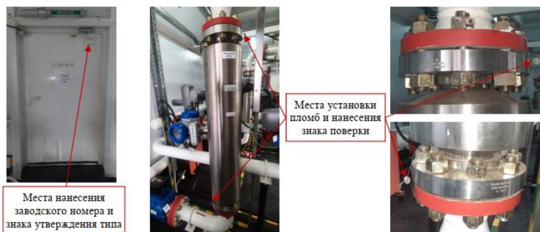
Рисунок 2 – Места нанесения заводского номера, знака утверждения типа, знака поверки и места установки пломб
