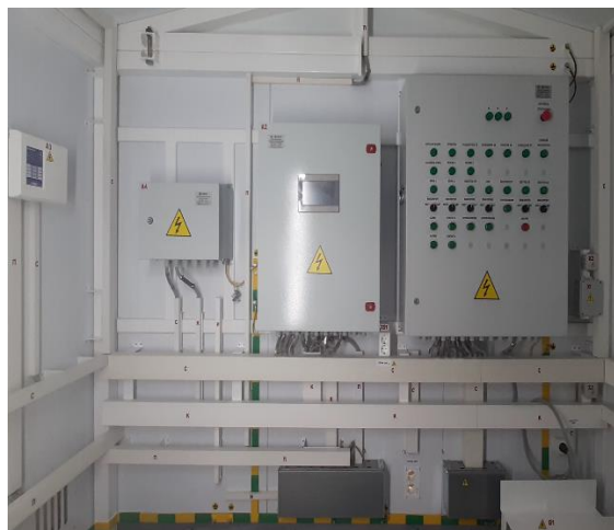
Рисунок 2 – Внешний вид оборудования БА общепромышленного исполнения
