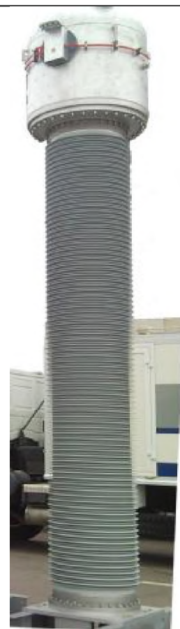
Рисунок 4. Общий вид трансформатора тока ТОГП-500
