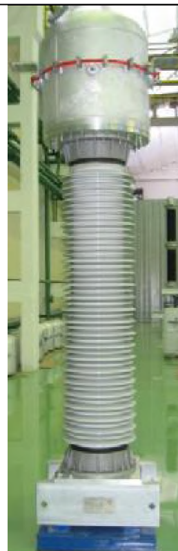
Рисунок 2. Общий вид трансформатора тока ТОГФ-220
