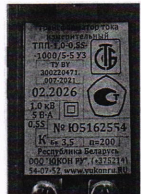
Рисунок 1.1 – Фотографии общего вида трансформаторов тока измерительных ТПП и ТПП-Н (изображение носит иллюстративный характер)
