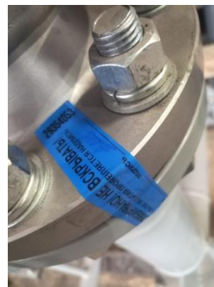
Рисунок 7 – Места и способы пломбирования, препятствующего демонтажу массового расходомера
