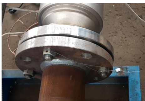
Рисунок 7 – Места и способы пломбирования, препятствующего демонтажу массового расходомера
