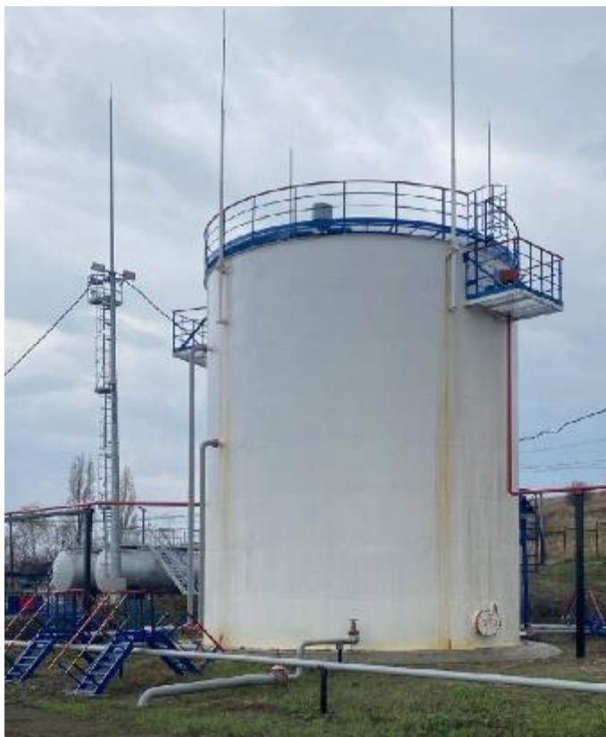
Рисунок 1 – Общий вид резервуара вертикального стального РВС-1000 заводской номер 1
