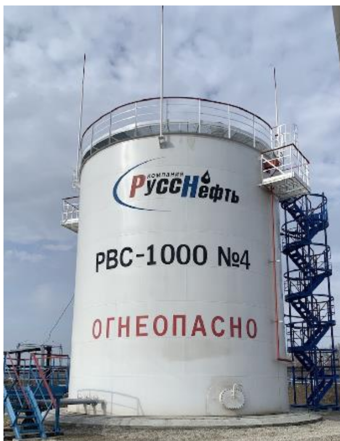
Рисунок 1 – Общий вид резервуара вертикального стального РВС-1000 заводской номер 4
