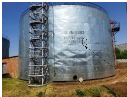
Рисунок 1 – Общий вид резервуара стального вертикального цилиндрического РВС-5000 и места нанесения заводского номера
