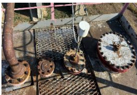
Рисунок 2 – Вид замерного люка и таблички с заводским номером резервуара горизонтального стального РГС-50 заводской номер 24497
