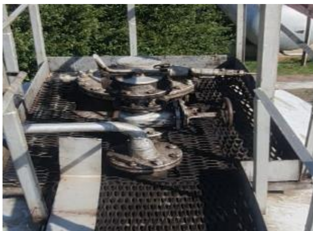
Рисунок 4 – Вид зачерного люка и место нанесения заводского номера резервуара горизонтального стального РГС-100 заводской номер 3922
