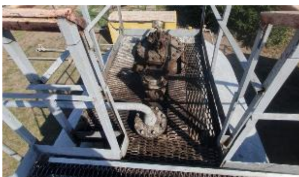
Рисунок 2 – Вид замерного люка и место нанесения заводского номера резервуара горизонтального стального РГС-100 заводской номер 3920
