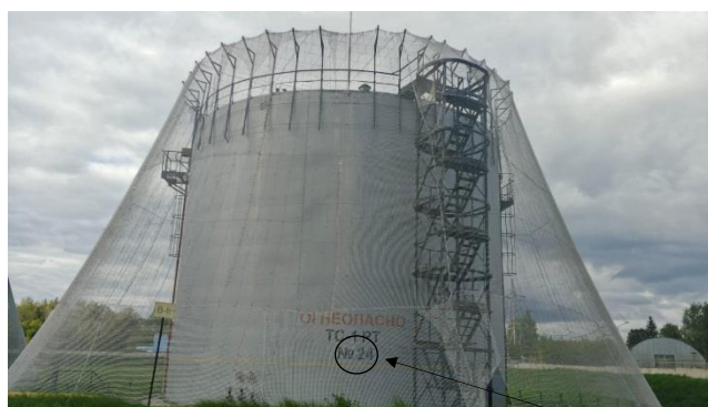
Рисунок 1 – Общий вид резервуара стального вертикального цилиндрического РВС-2000 и места нанесения заводского номера
