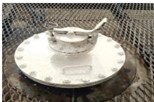
Рисунок 2 – Вид замерного люка и место нанесения заводского номера резервуара горизонтального стального РГС-95 заводской номер 1441
