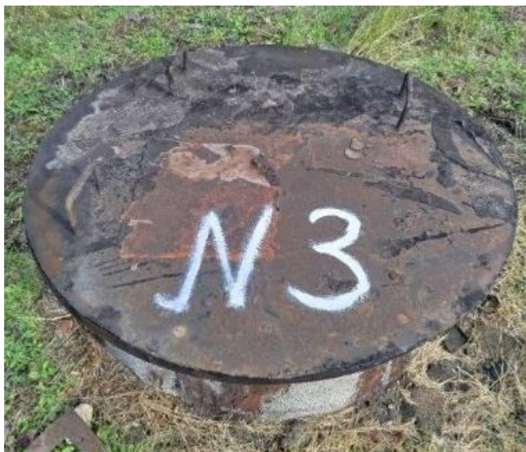
Рисунок 3 – Горловина резервуара РП-10000 зав. № 3
