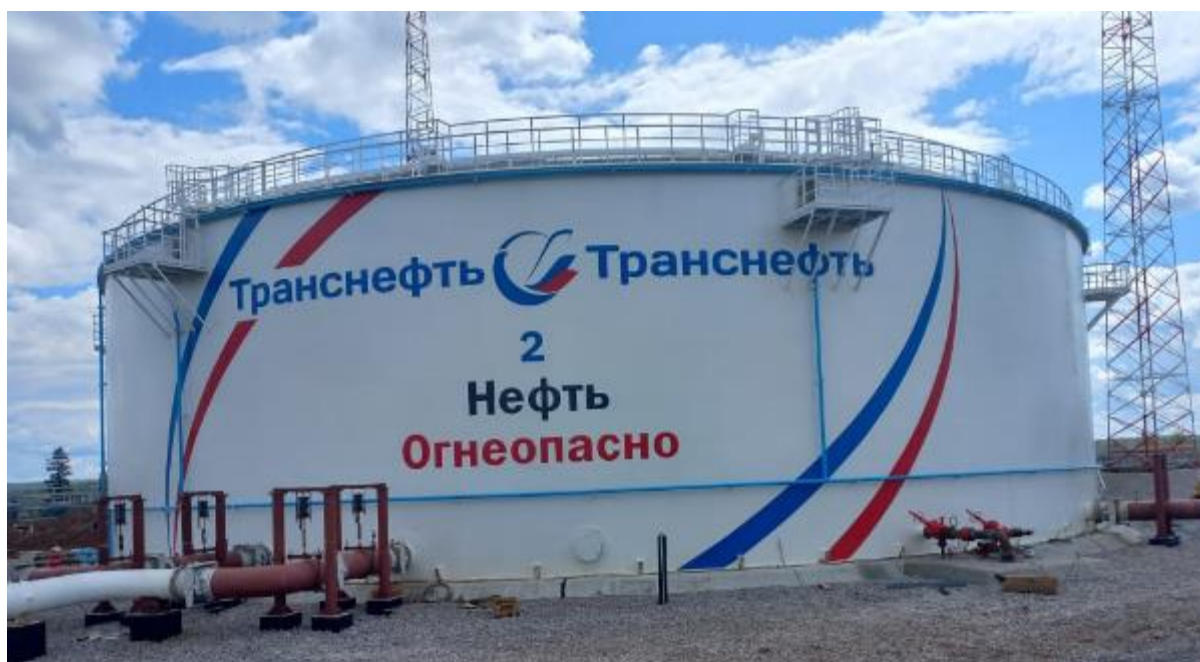
Рисунок 1 – Общий вид резервуара РВС-20000 № 2
