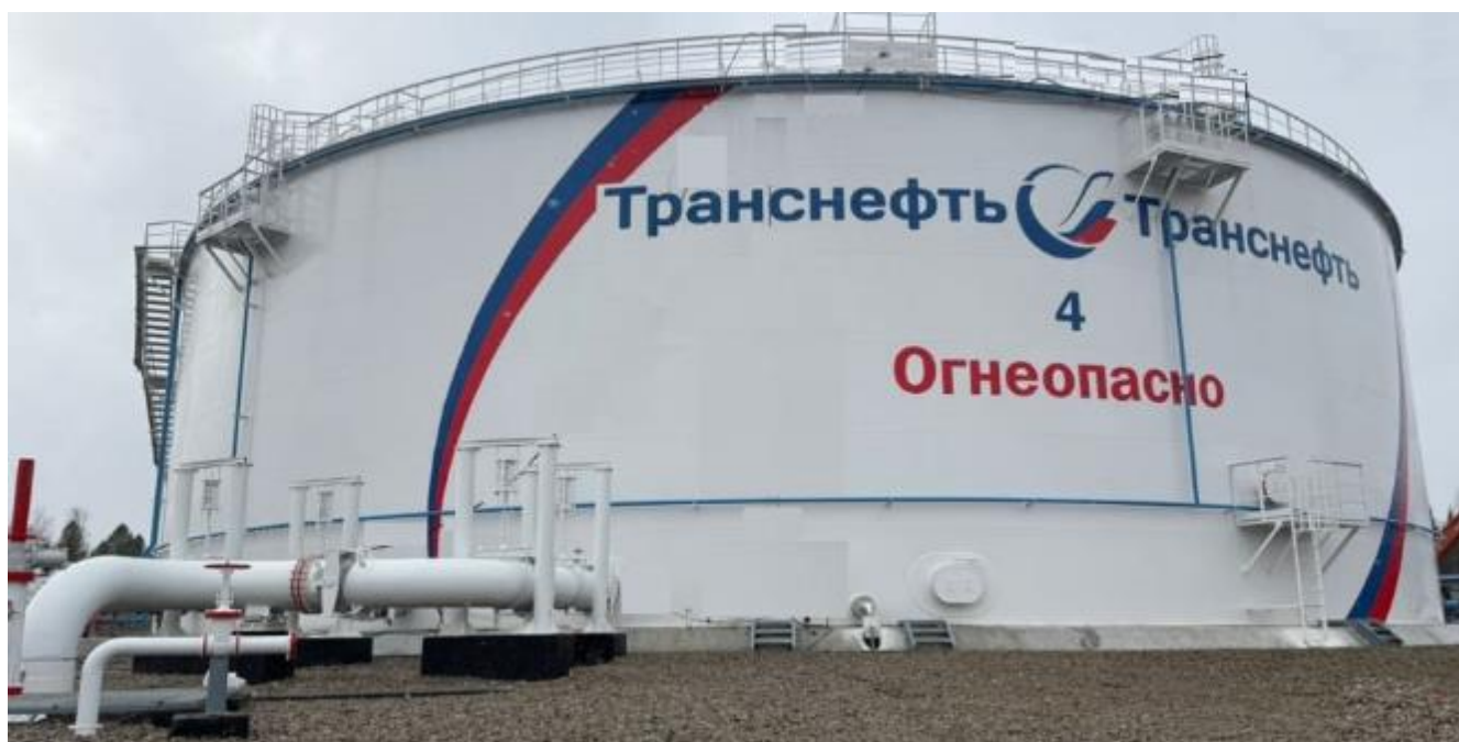
Рисунок 2 – Общий вид резервуара РВСП-20000 № 4
