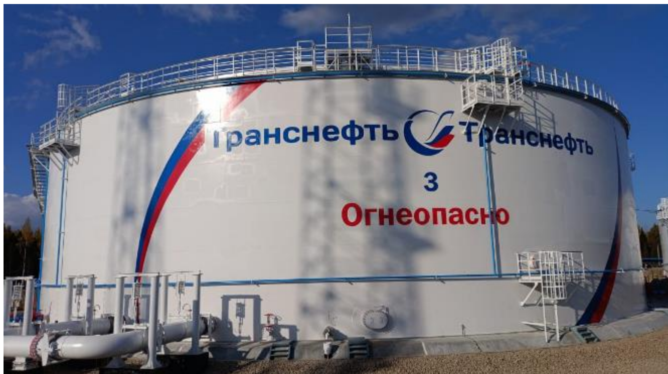
Рисунок 1 – Общий вид резервуара РВСП-20000 № 3
