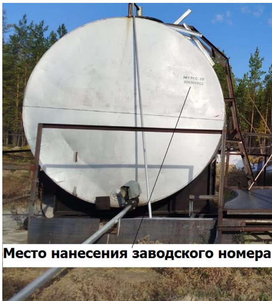
Рисунок 1 – Общий вид резервуара горизонтального стального цилиндрического РГС-25 с указанием места нанесения заводского номера
