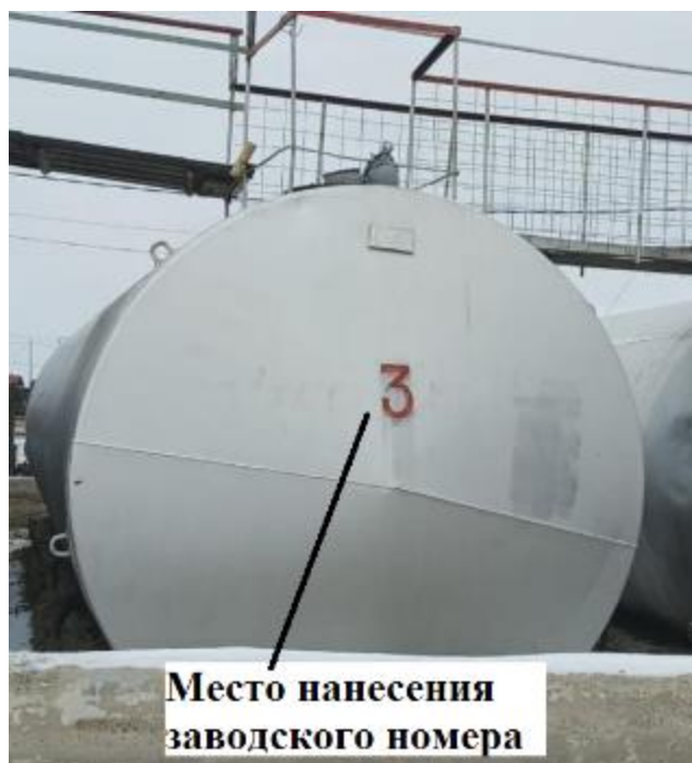
Рисунок 1 – Общий вид резервуара горизонтального стального цилиндрического РГС-60 с указанием места нанесения заводского номера
