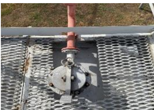
Рисунок 4 – Вид замерного люка и место нанесения заводского номера резервуара горизонтального стального РГС-60 заводской номер 2
