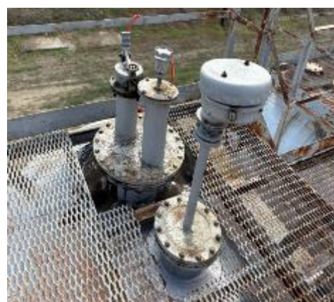
Рисунок 1 – Общий вид резервуара, замерного люка и места нанесения заводского номера резервуара горизонтального стального РГС-57 заводской номер 4
