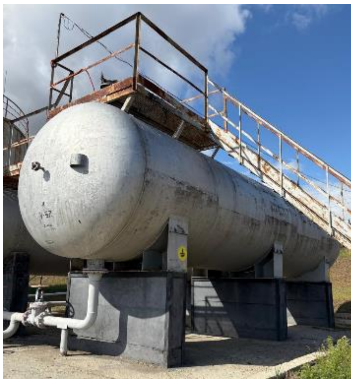
Рисунок 1 – Общий вид резервуара, замерного люка и места нанесения заводского номера резервуара горизонтального стального РГС-57 заводской номер 4
