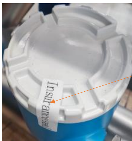
Рисунок 2 – Пломбировка массовых расходомеров
