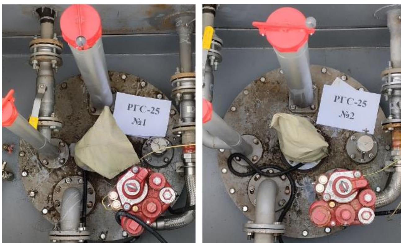
Рисунок 2 – Горловины резервуаров РГС-25 зав.№№ 1, 2
