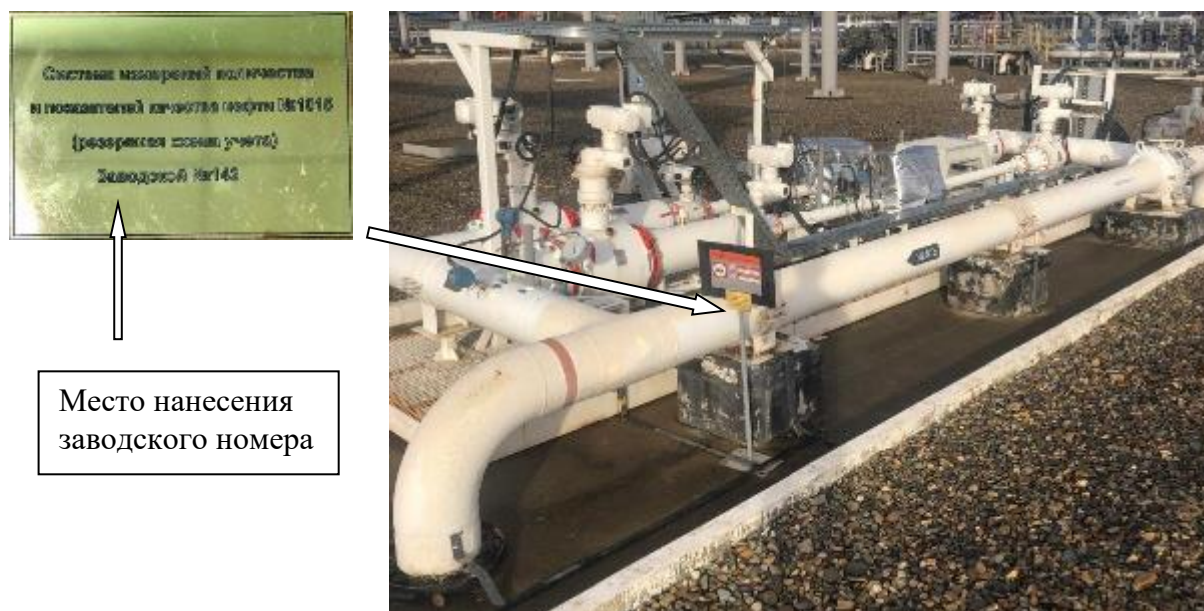
Рисунок 1 – Общий вид системы с указанием места нанесения заводского номера
