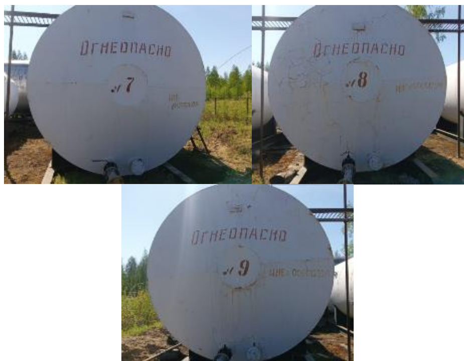
Рисунок 1 – Общий вид резервуаров горизонтальных стальных цилиндрических РГС-50 с указанием места нанесения заводских номеров
