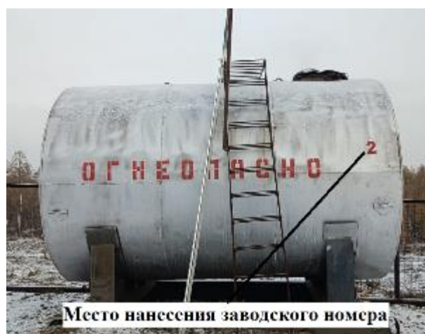
Рисунок 2 – Общий вид резервуара горизонтального стального цилиндрического РГС-25 с указанием места нанесения заводского номера
