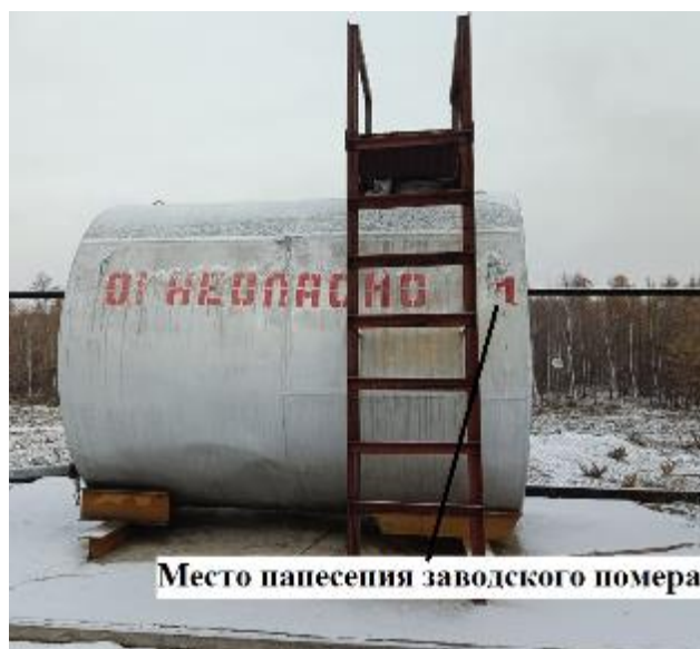
Рисунок 1 – Общий вид резервуара горизонтального стального цилиндрического РГС-10 с указанием места нанесения заводского номера
