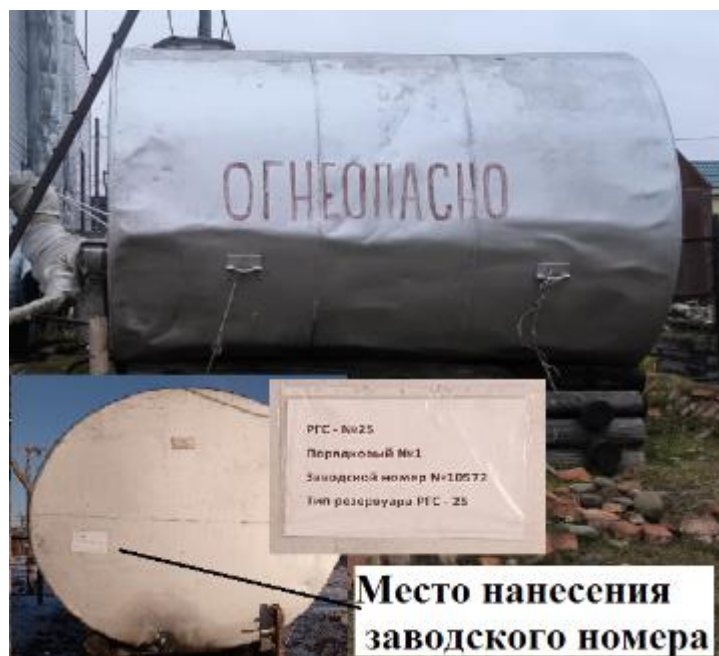
Рисунок 1 – Общий вид резервуара горизонтального стального цилиндрического РГС-25 с указанием места нанесения заводского номера
