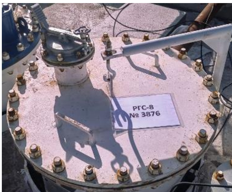
Рисунок 1 – Место нанесения заводского номера резервуара
