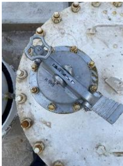
Рисунок 2 – Замерной люк резервуара
